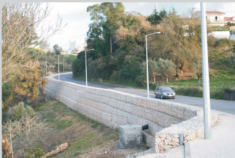
Muro, passeios e iluminação na Rua de São João, Eiras da Lagoa - Devido ao perigo de deslizamento, esta obra assumiu um carácter urgente.
