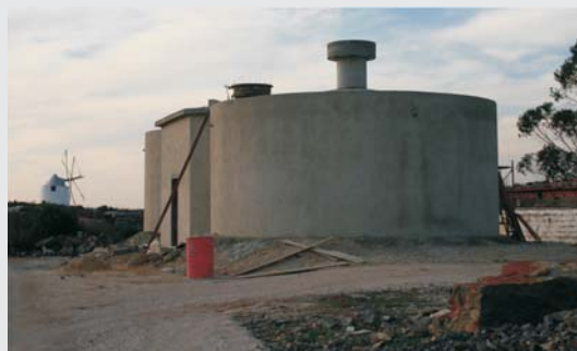
Depósito de água no Alqueidão da Serra
