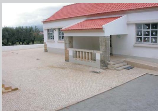
Arranjos exteriores na Escola EB1 da Mendiga
