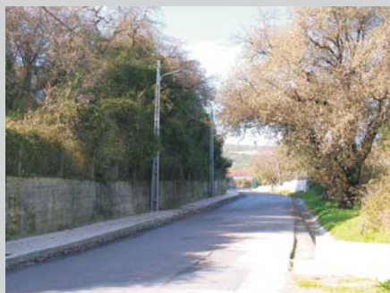
Calçetamento na Rua da Calçada Corredoura
