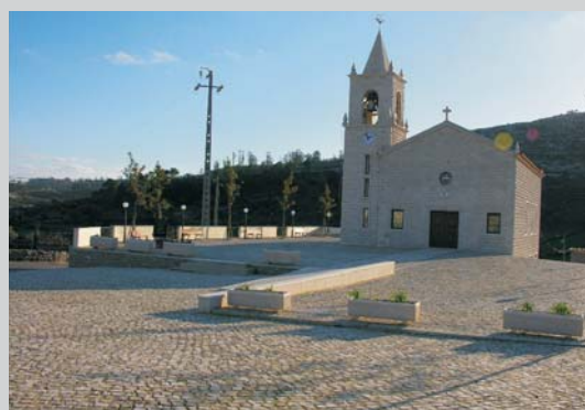
Arranjos exteriores no largo da Igreja do Chão das Pias
