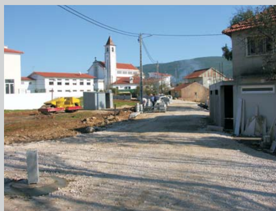
Esgotos e alargamento da via, em Pedreiras - obra em execução
