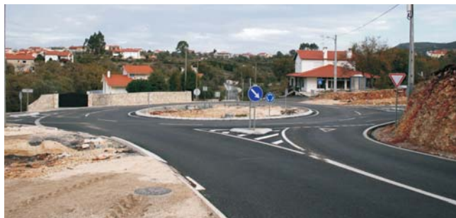
Execução da Rotunda do Major - Alqueidão da Serra
