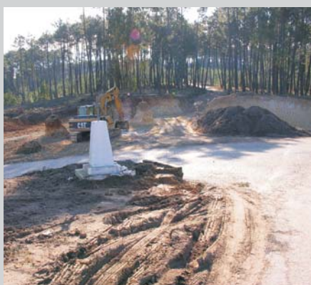
Rotunda da Cruzinha, em Juncal - Obra em execução
