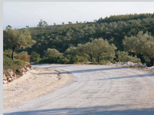
Alargamento da estrada e rectificação de curvas, em São Bento Obra em execução
