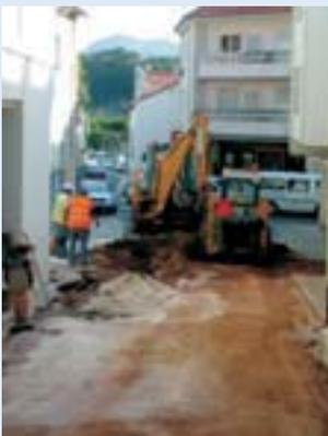
As obras de requalificação da Praça da República permitiram a introdução de uma nova rede de águas pluviais, até agora inexistente, de que é exemplo a intervenção efectuada na Rua 5 de Outubro. Procura-se, num futuro próximo, dotar a vila de duas redes pluviais e residuais, completamente distintas.
