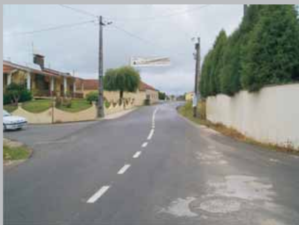
Pavimentação da Estrada do Tojal de Cima - Carqueijal
