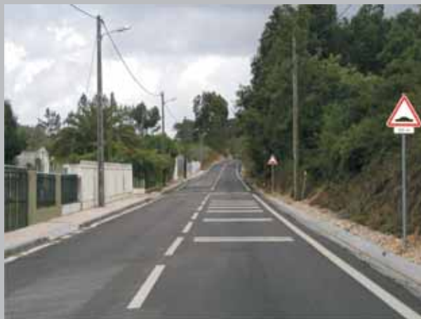
Pavimentação da estrada do Juncal - Concluída
