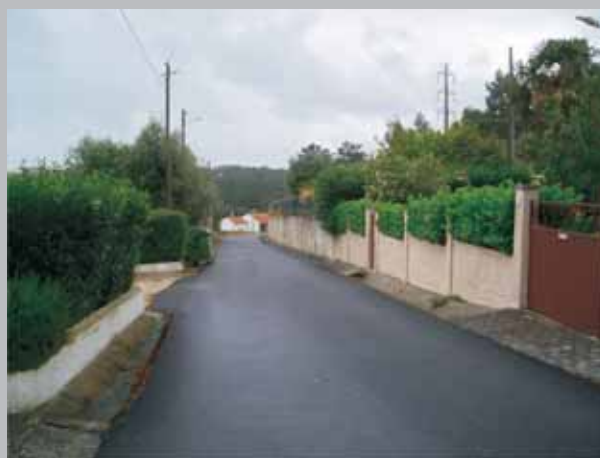
Pavimentação da estrada do Tojal de Baixo – São Jorge
