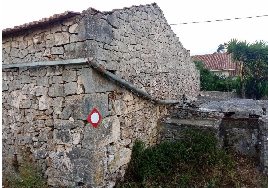
Figura 13: Antiga habitação com cisterna alimentada por caleira.
