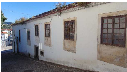
Figura 23- Edifício Degradado, Calçada Santa Isabel
