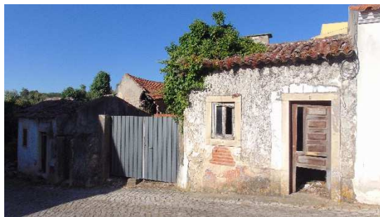
Figura 21- Edifício em Ruína, Rua do Cid
