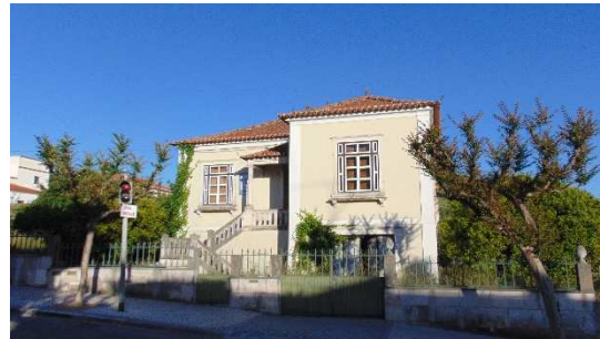
Figura 26- Edifício Desocupado, Avenida da Liberdade
