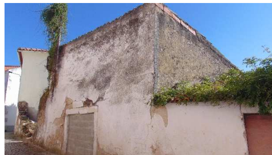
Figura 22- Edifício Desmoronado, Rua Conceição Abreu
