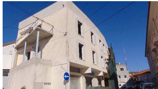
Figura 30- Edifício Reabilitado, Rua Mestre de Aviz
